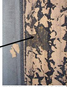
FIGURE 6-11. ENLARGED PORTION OF CRACKED ASPHALT.
