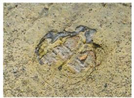
FIGURE 6-7. MULTIPLE LAYERS OF PAINT FILL THE GROOVES.
