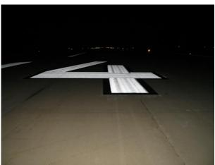
FIGURE 6-52. NIGHTTIME VISIBILITY OF FIGURE 6-51 IS EXCELLENT.
