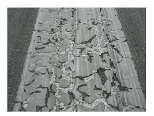
FIGURE 4-7. MANY LAYERS OF PAINT ON ASPHALT.
